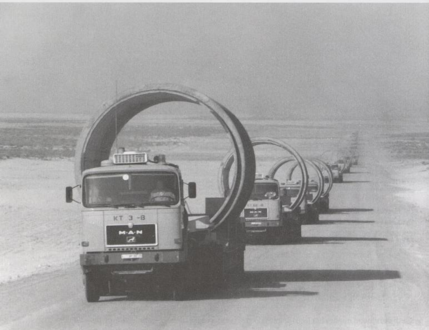
Transport av betongelementer under byggingen av Great Man Made River, Libya
